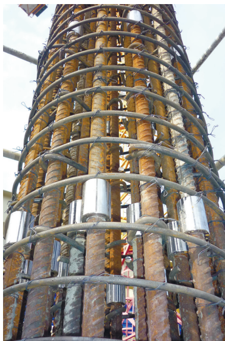
ГРАД - GRAD - Муфтовые соединения арматуры в колоннах
